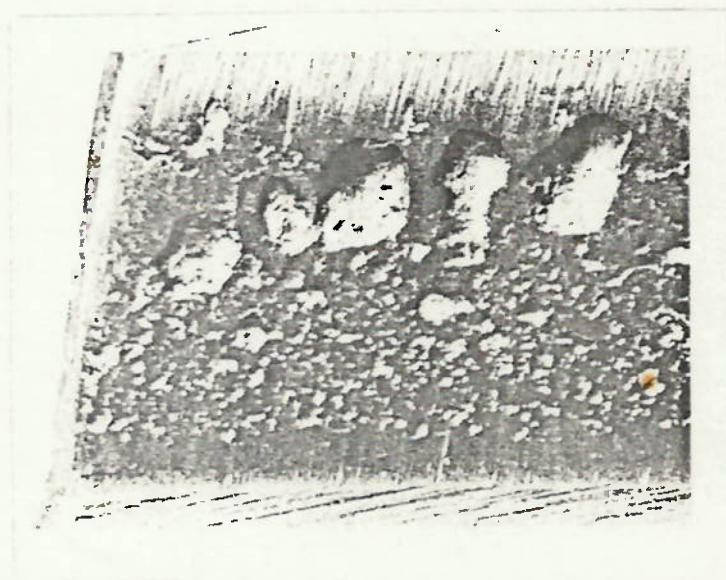
Figura 4 - "Pitting" destrutivo no flanco de dente de uma engrenagem cilíndrica de dentes retos, beneficiada.
